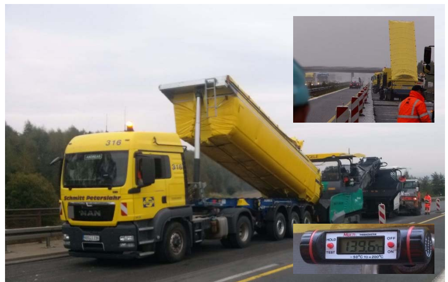
Mischguttransport mit Thermomulde, Einbau mit bis zu 2x Beschicker und Fertiger für geringe Stillstandszeiten
